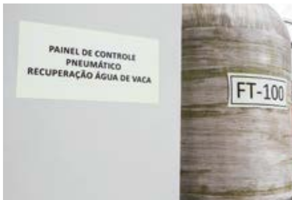
Equipamento de tratamento da água extraída na produção do Leite em Pó e do Leite Condensado Nestlé
